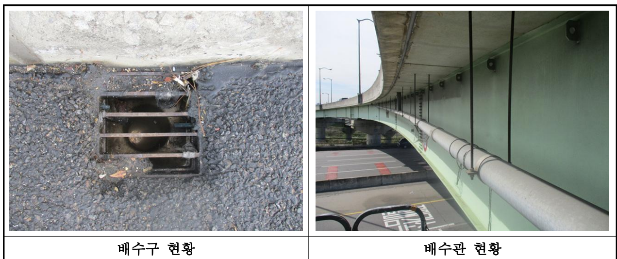
【사진 3.23】 배수구 및 배수관 전경
