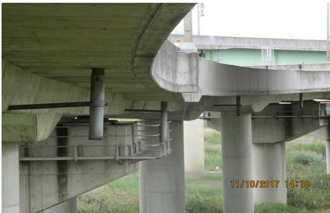
배수시설 전경 (산악형)
