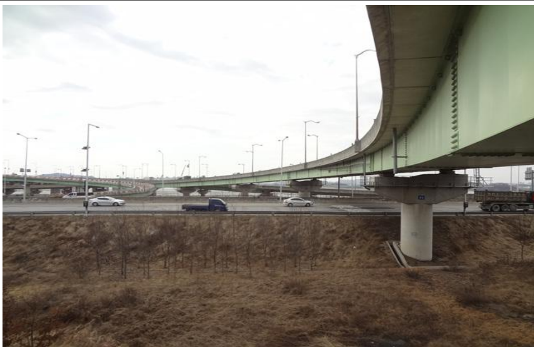
바닥판하면 및 거더 외부 전경(S1~5)
