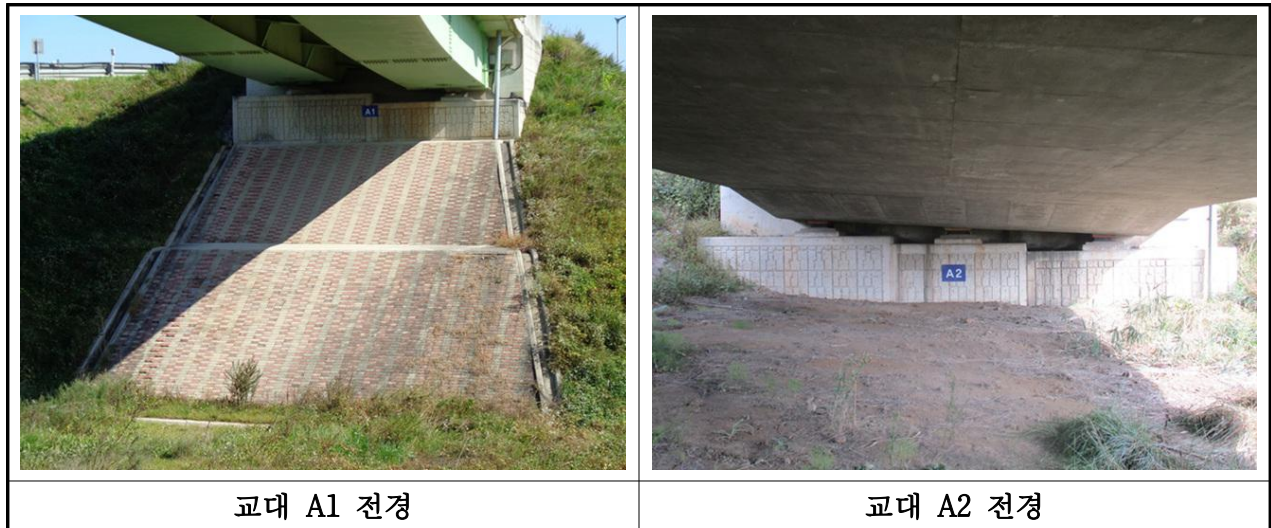
【사진 3.11】 교대 전경
