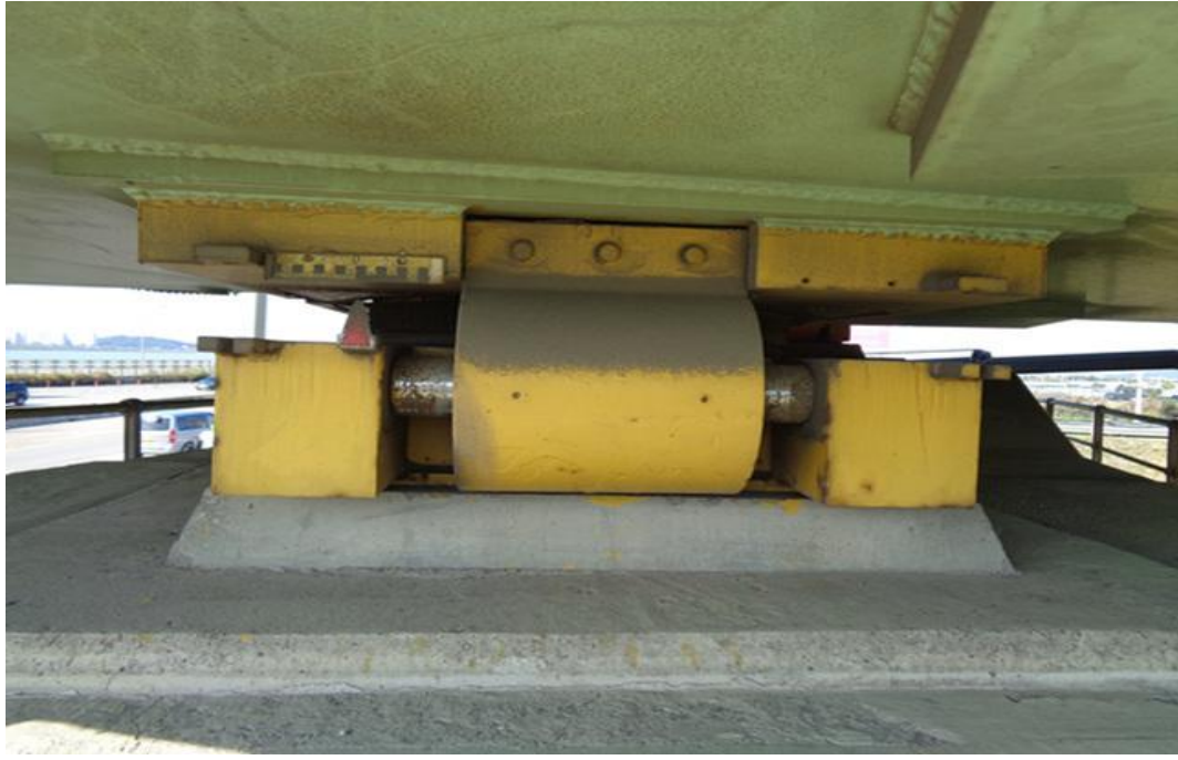
교량받침 전경 (내진받침)
