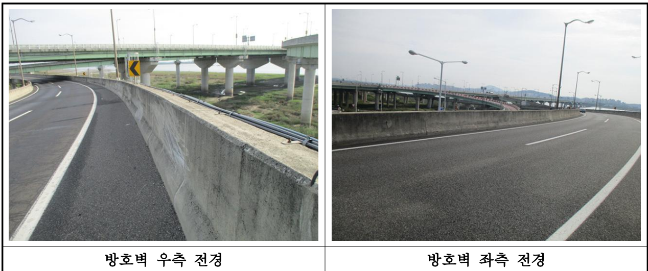
【사진 3.25】 방호벽 전경
