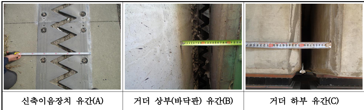
【사진 3.19】 신축이음 유간 측정방법
