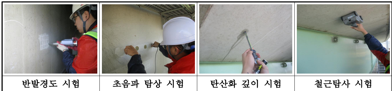
【사진 3.28】 콘크리트 내구성조사 전경
