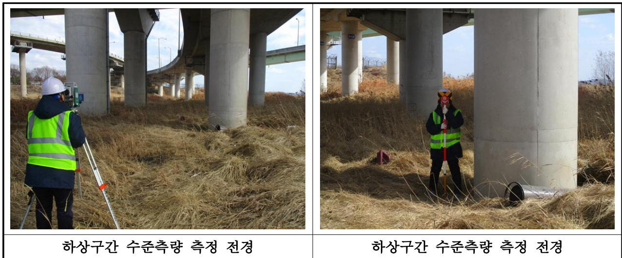
【사진 3.27】 하상구간 수중측량 측정 전경
