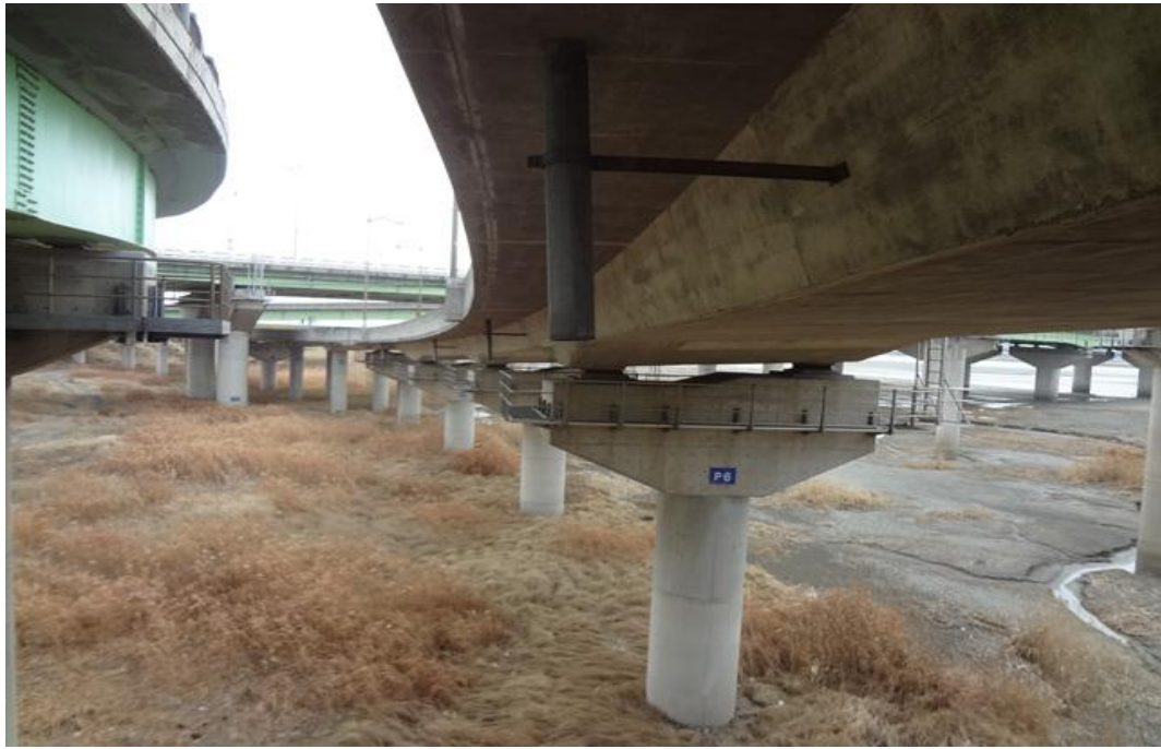
바닥판하면 전경(S6~9, S16~26)
