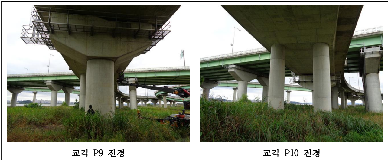
【사진 3.13】 교각 전경
