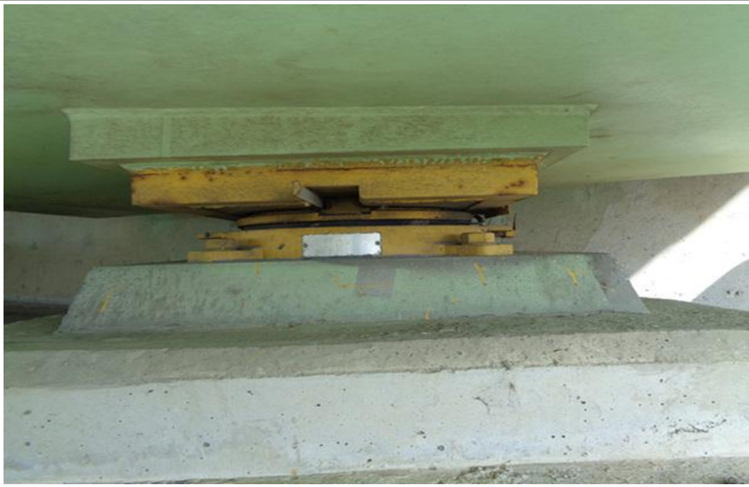
교량받침 전경 (포트받침)
