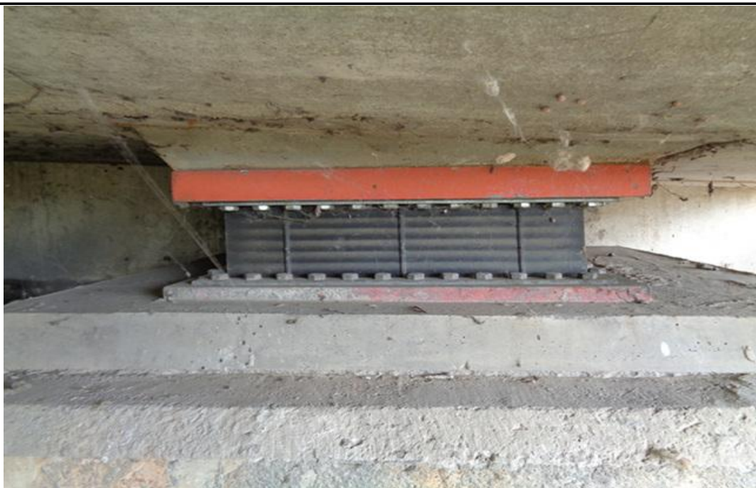
교량받침 전경 (탄성받침)
