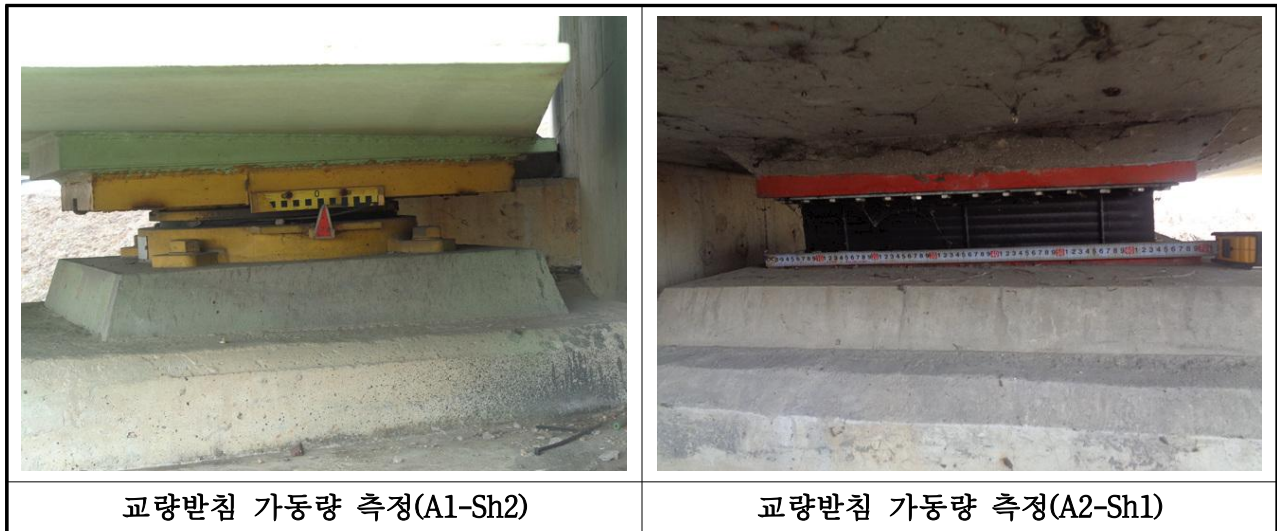
【사진 3.16】 교량받침 가동량 측정 전경
